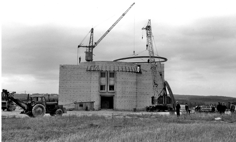
Foto 1. Kupli pööramise relsi tõstmine torni peale.
